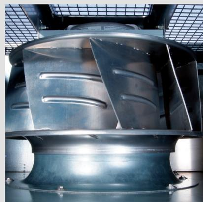
Ventilador EC sin mantenimiento
